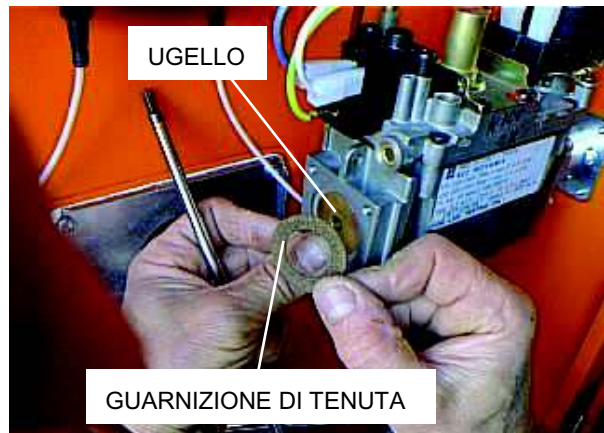
Figura 26 – Sostituzione ugello
