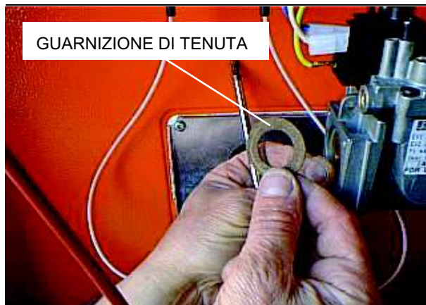
Figura 25 – Guarnizione di tenuta
